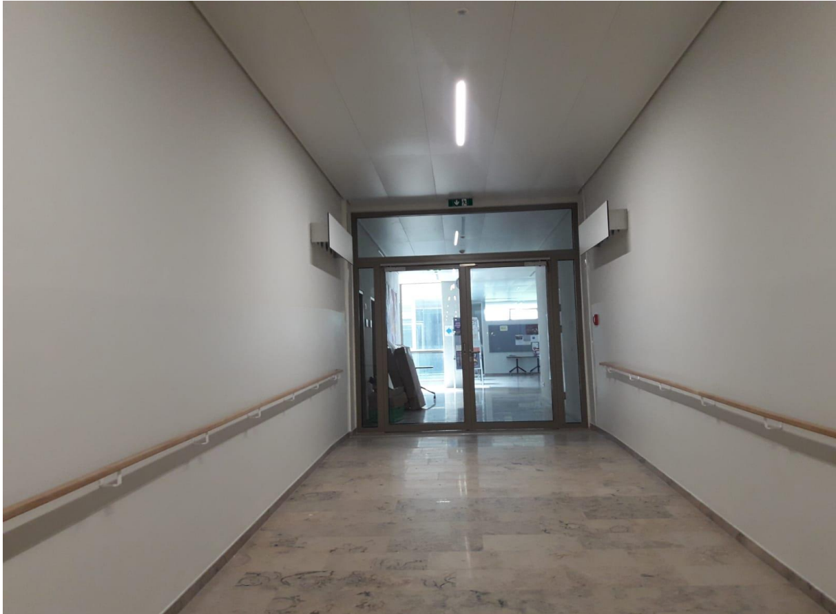
Abbildung 5.7: Gangansicht des Überströmelements für das Klassenzimmer 02.225 (Klassenbester, 2024)
