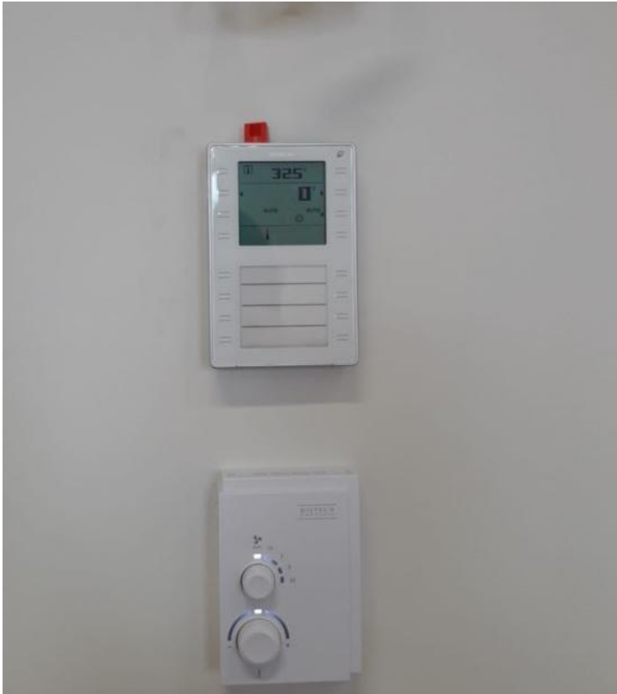
Abbildung 5.6: Raumsensor + Raumregler für das Klassenzimmer 02.225 (Klassenbester, 2024)
