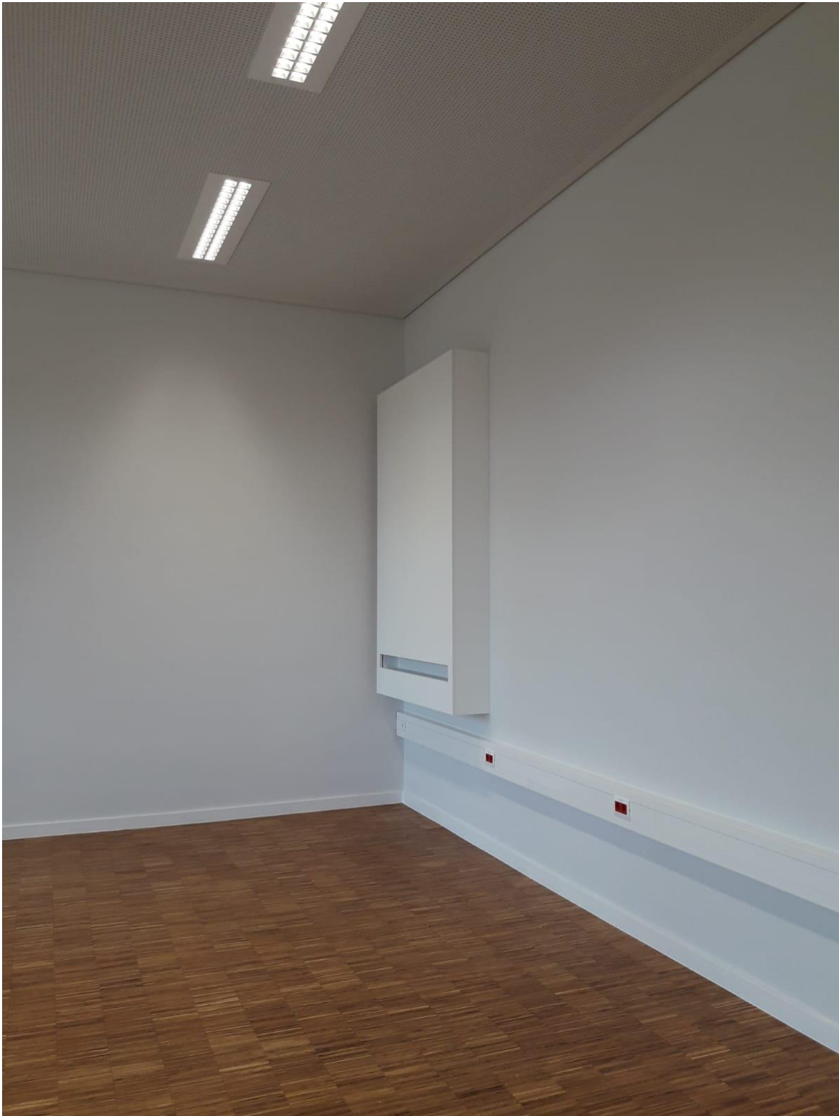
Abbildung 5.3: Überströmelement des Klassenzimmers 01.127 (Klassenbester, 2024)
