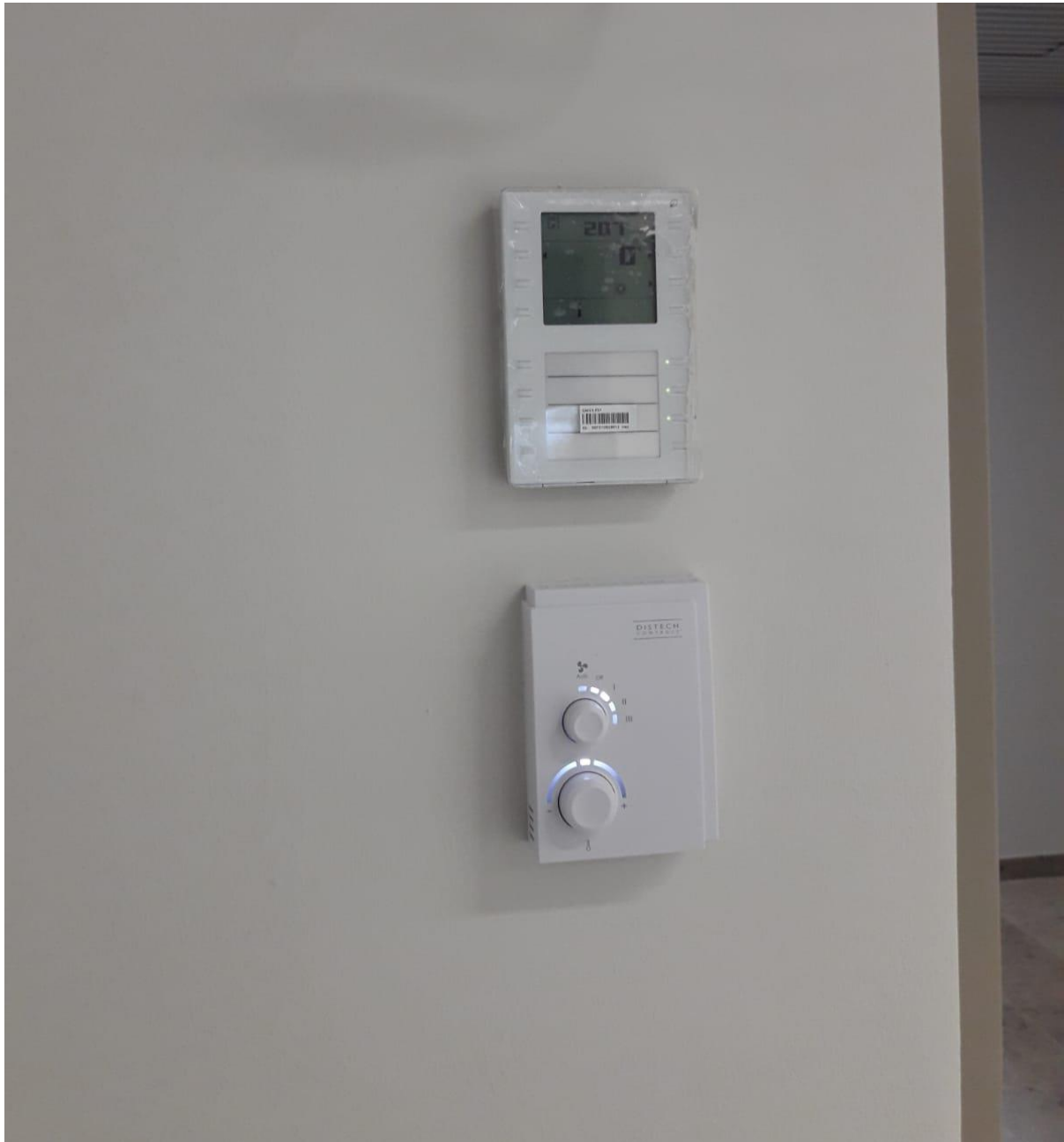
Abbildung 5.2: Fotoaufnahme des Raumsensors + Raumregler für das Klassenzimmer 01.127 (Klassenbester, 2024)
