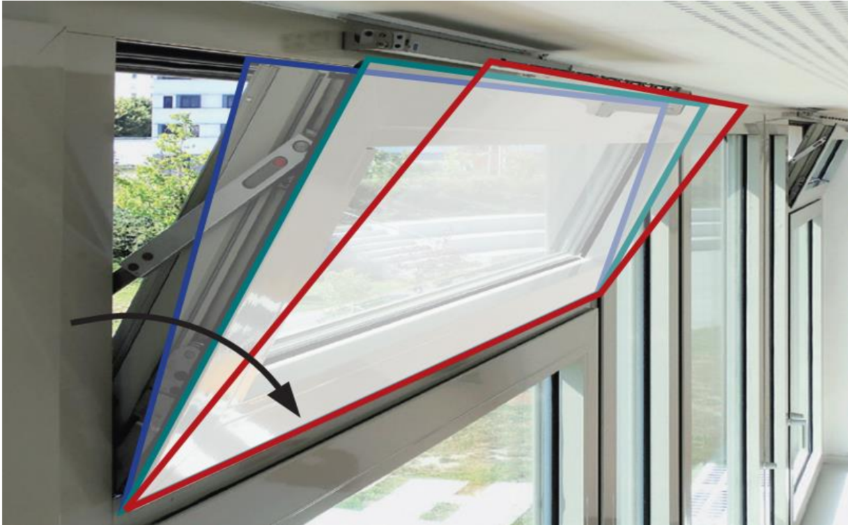
Abbildung 3.3: Kippstellung eines motorgesteuerten Oberlichts (Klassenbester, 2024)
